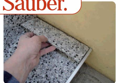
Sockelelemente auf Länge schneiden und mit dem PU-Kleber an die Wand kleben.
